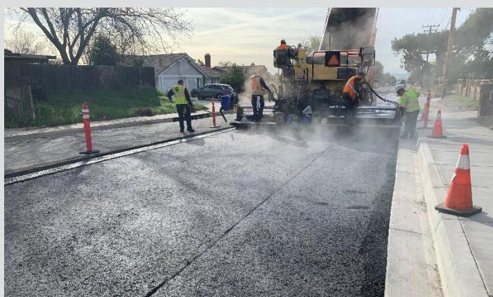
**PASO 3 & 4** Las carreteras se pavimentan, luego se compactan con un rodillo
